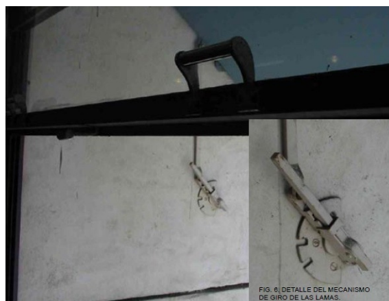
Sistema de persiana parasol móvil manual. En la fotografía de la izquierda se muestra sistema de movimiento manual. Fotografías obtenidas de Análisis ambiental propuesto para Ministerio de Educación de Rio de Janeiro Brasil, Escuela de Arquitectura, Sevilla España
