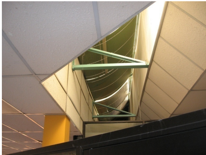
Pese a que las claraboyas tienen persianas cerradas, existe un aprovechamiento de la luz solar
