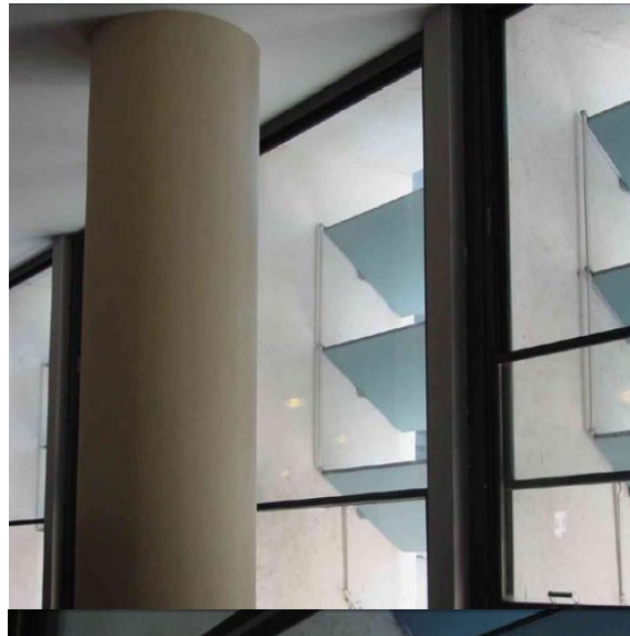
Sistema de persiana parasol móvil manual. En la fotografía de la izquierda se muestra sistema de movimiento manual. Fotografías obtenidas de Análisis ambiental propuesto para Ministerio de Educación de Rio de Janeiro Brasil, Escuela de Arquitectura, Sevilla España
