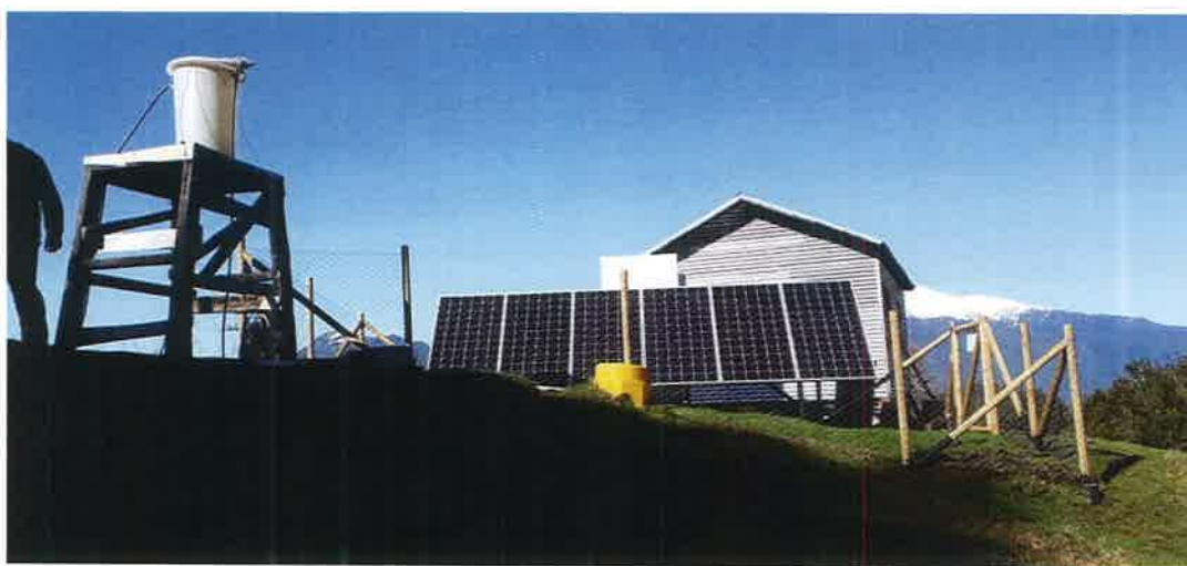
Imagen 7: Ejemplo sistema solar fotovoltaico
