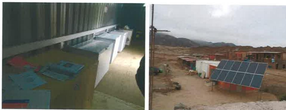
*Figura 6: imagen de la solución de energización fotovoltaica para refrigeración modular*
