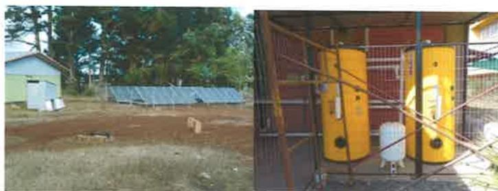
*Figura 3: Colectores solares a la izquierda y depósito acumulador a la derecha*
